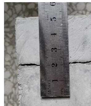
(d) End delamination
