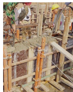
(d) Concrete casting
