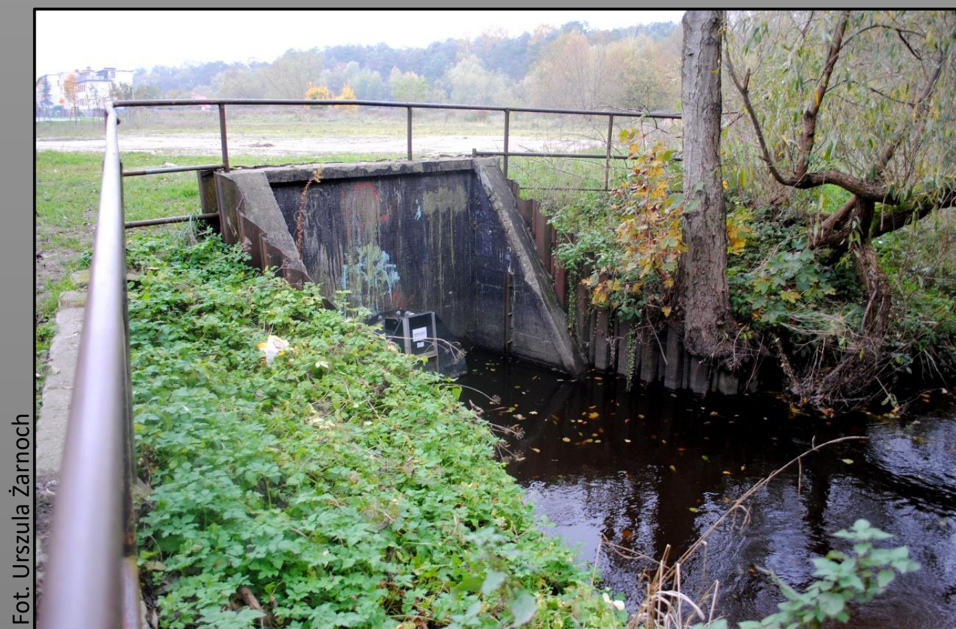
Wylot kanalizacji deszczowej do rzeki Redy. W tle widoczny jest plac znajdujący się również na zdjęciu powyżej.
