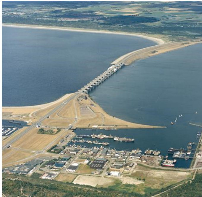
Figure 2. Haringvlietdam from the sky. Source: Rijkswaterstaat Beeldbank. Image reproduced with permission of Rijkswaterstaat.
