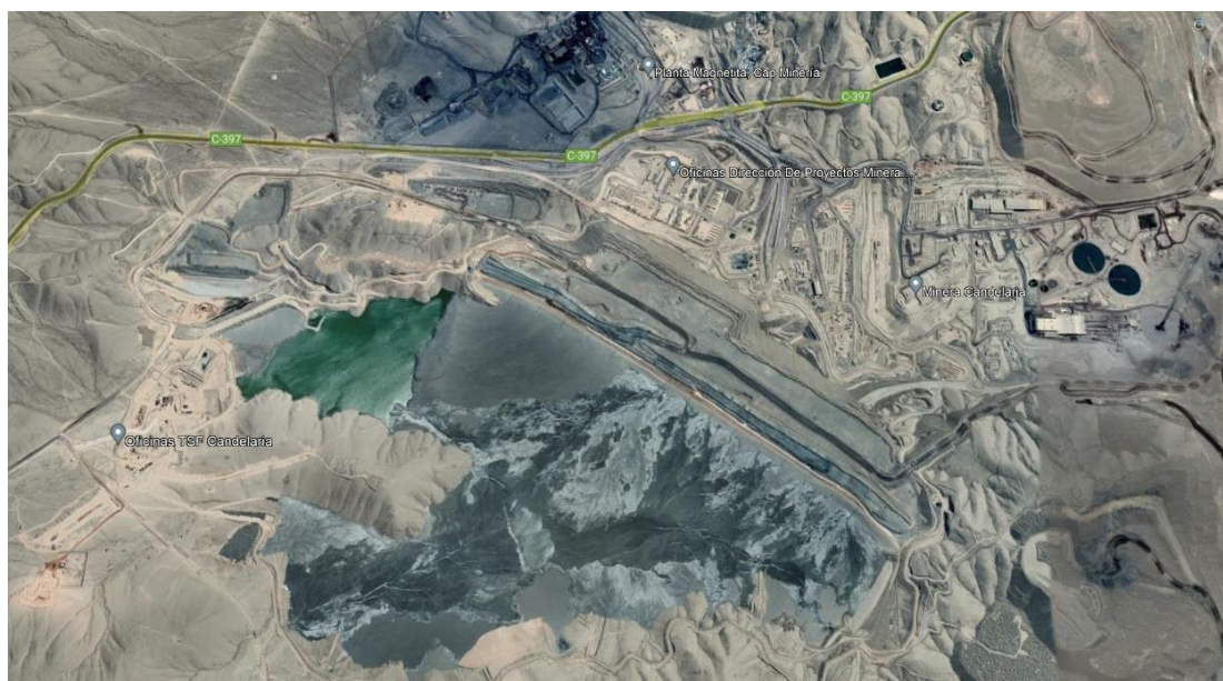
Figure 37. Los Diques Thickened TSF.
