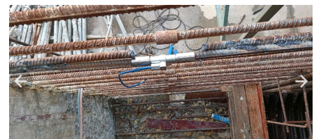
(d) Vibrating string steel bar meter
