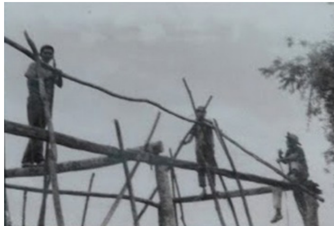
Figure 1. Old picture of a vernacular construction in Cordoba. Centro de Documentación Regional Orlando Fals Borda-Banco de la República Montería. Folder p. 23 [2].
