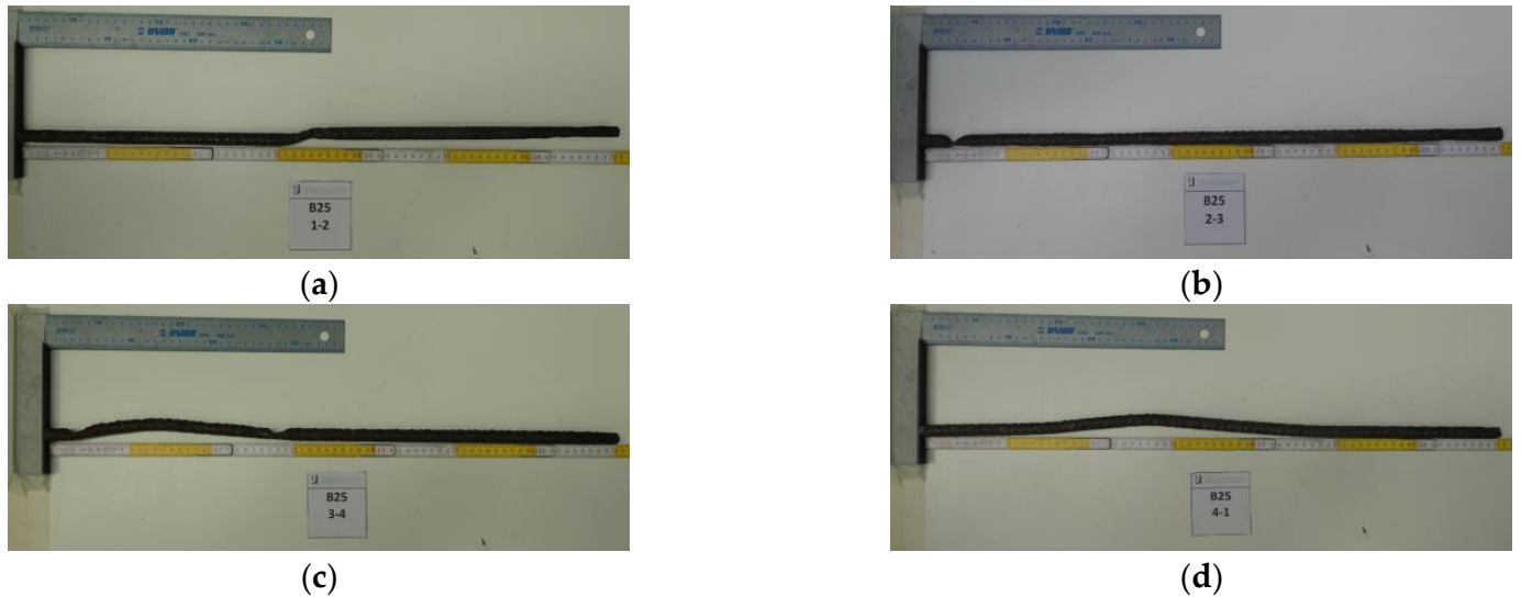
Figure 5. Corroded Rebars, Column B25. (a) Bar 1-2, (b) Bar 2-3, (c) Bar 3-4, (d) Bar 4-1.
