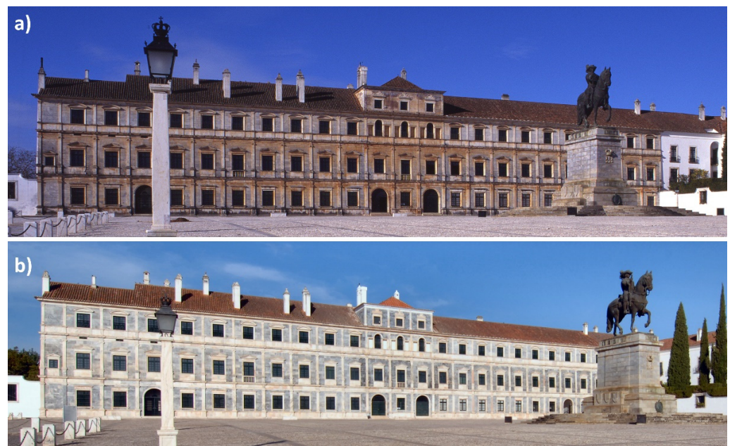
Figure 1. Façade of the Paço Ducal de Vila Viçosa (Portugal): (a) before and (b) after the cleaning intervention (©Fundação da Casa de Bragança).
